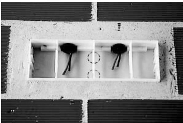
Retirar las traviesas
